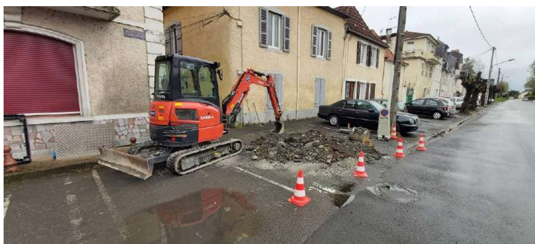
Réalisation d'un branchement d'eau à Nay.
