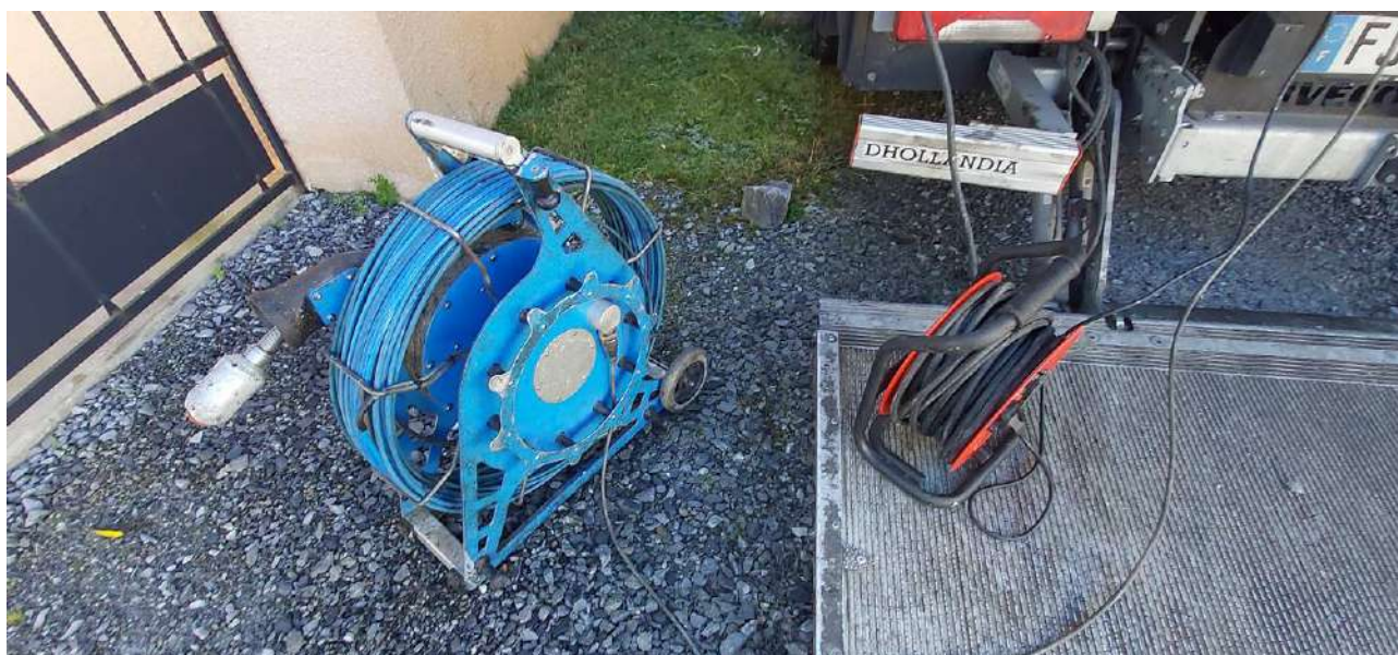
Passage de caméra dans les réseaux.
