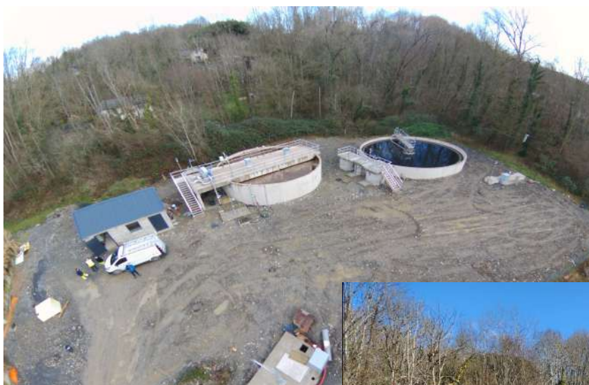
Travaux de réhabilitation de la STEP d'Asson 2 000 EH
