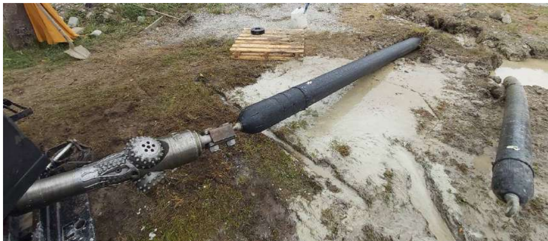
Forages dirigés pour passer les réseaux d'eau et d'assainissement sous l'Ouzom à Igon
